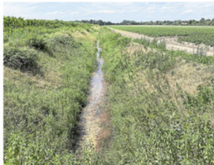
Wo ist das Wasser? Entwässerungsgräben wie dieser im westlichen Meppen zeigen an, wo das Problem liegt: Das Wasser steht fast zwei Meter unter der Geländeoberkante.
